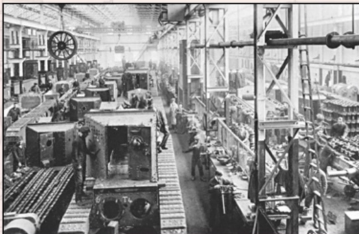
Een blik in de Foster fabriek met Whippet tanks in verschillende stadia van bewerking.
