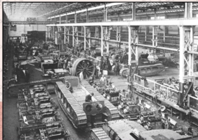
Een blik in de Foster fabriek met Whippet tanks in verschillende stadia van bewerking.
